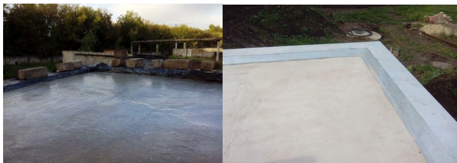
Рис.1 Вид свежееуложенной бетонной смеси покрытой латексом (слева) и готовой кровли (справа)
