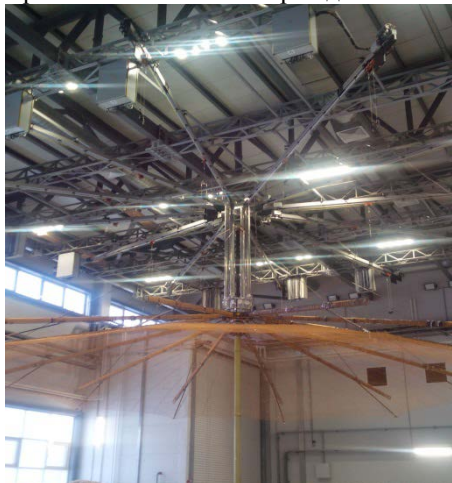
Рисунок 5 – Внешний вид системы обезвешивания с закрепленным рефлектором.
