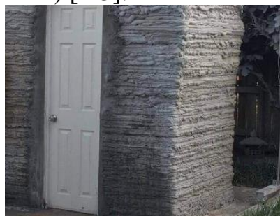
Рисунок 2 – Наплывы на поверхности слоев
